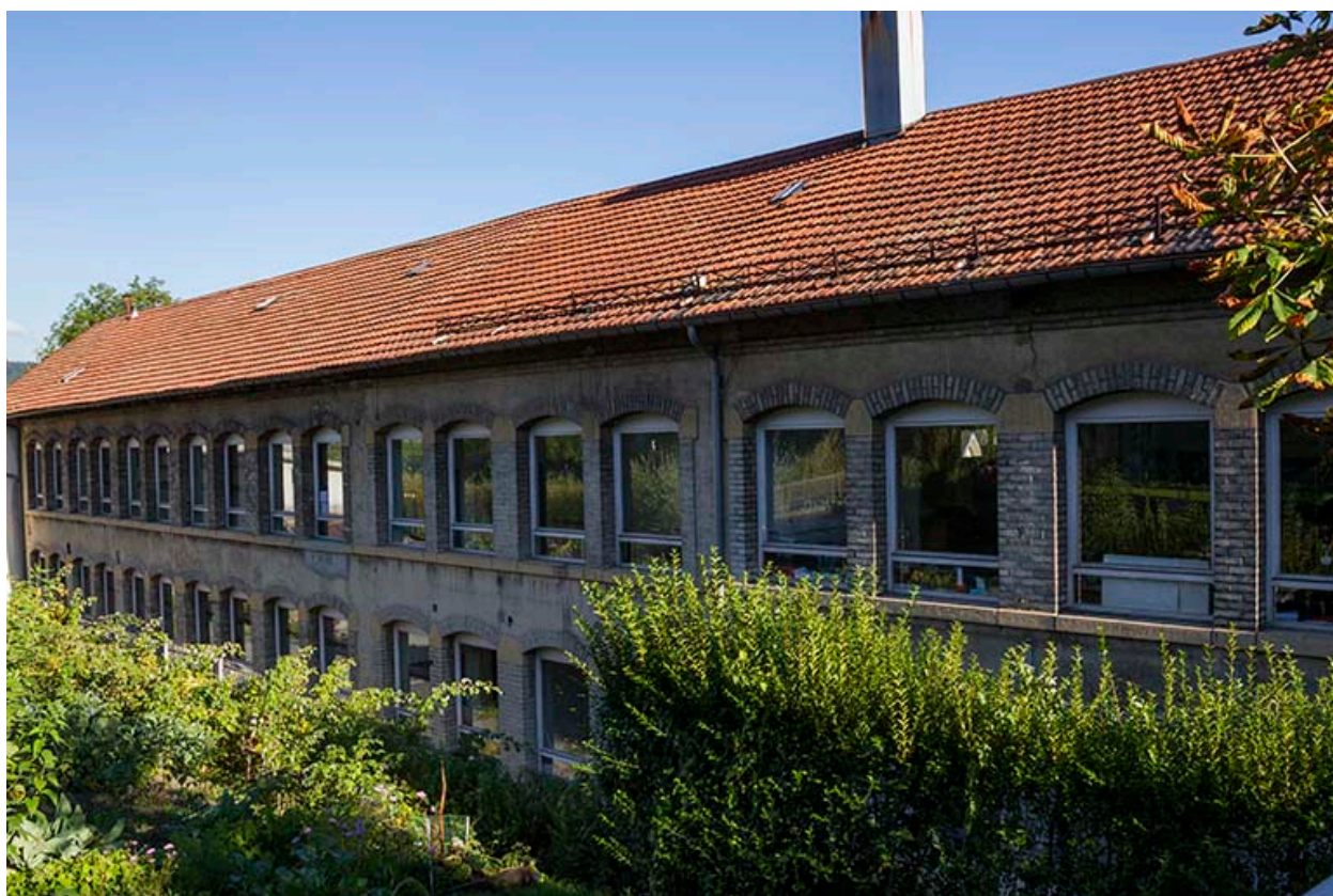
Aile nord : façade postérieure.
