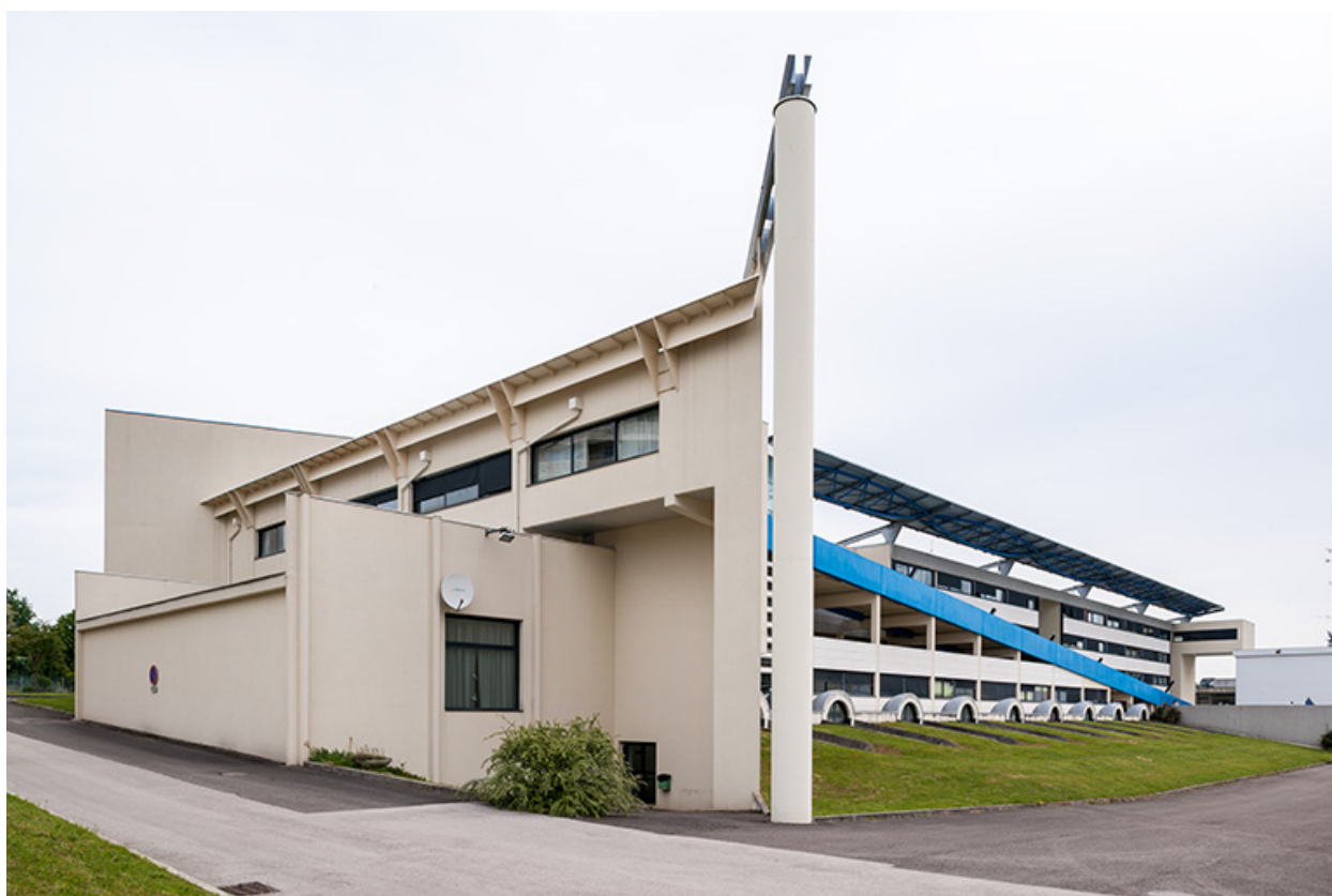
Bâtiment d'externat : pignon ouest.
