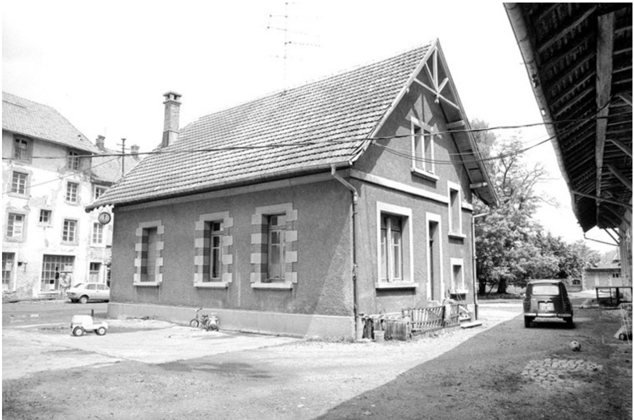
Bureaux en 1980.SRI. Enquête régionale sur les bâtiments industriels (1979-1981).
