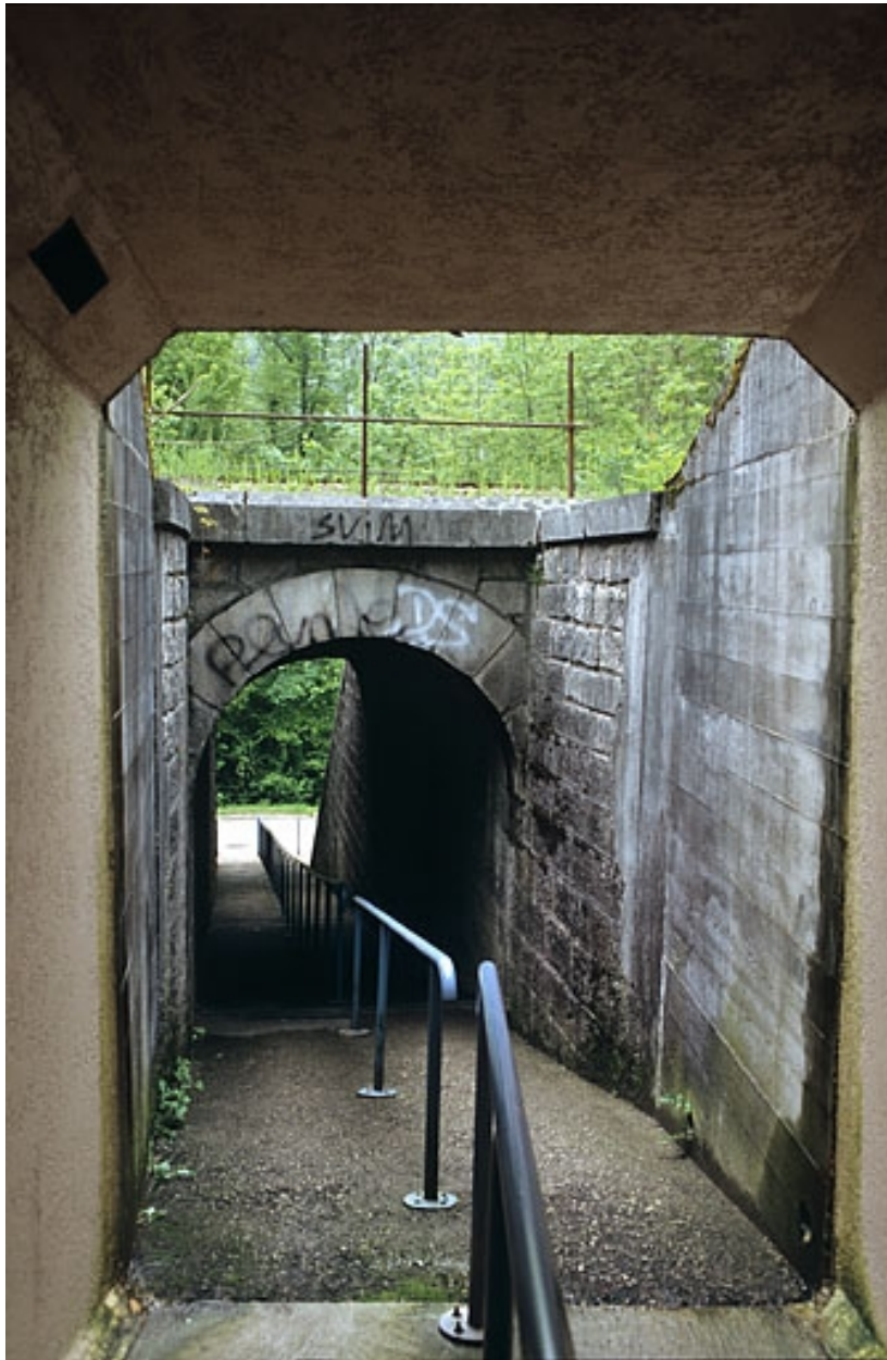
Tête amont (sud), depuis le passage sous la route de Lyon.
