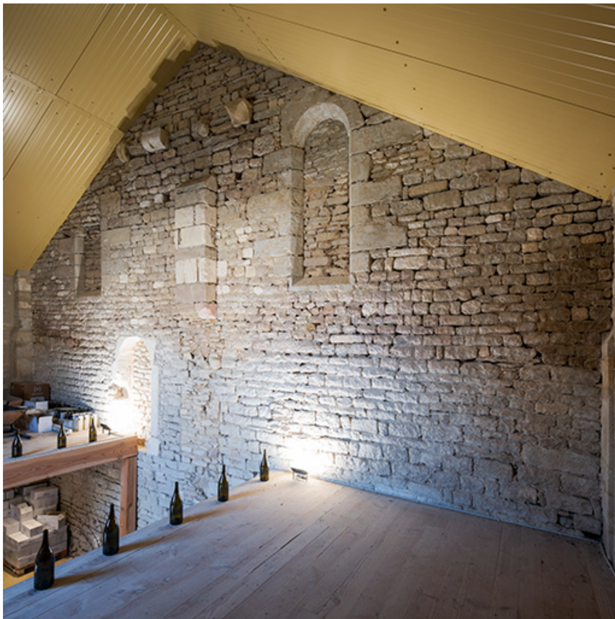
Mur nord de l'église, côté extérieur, dans une ferme.
