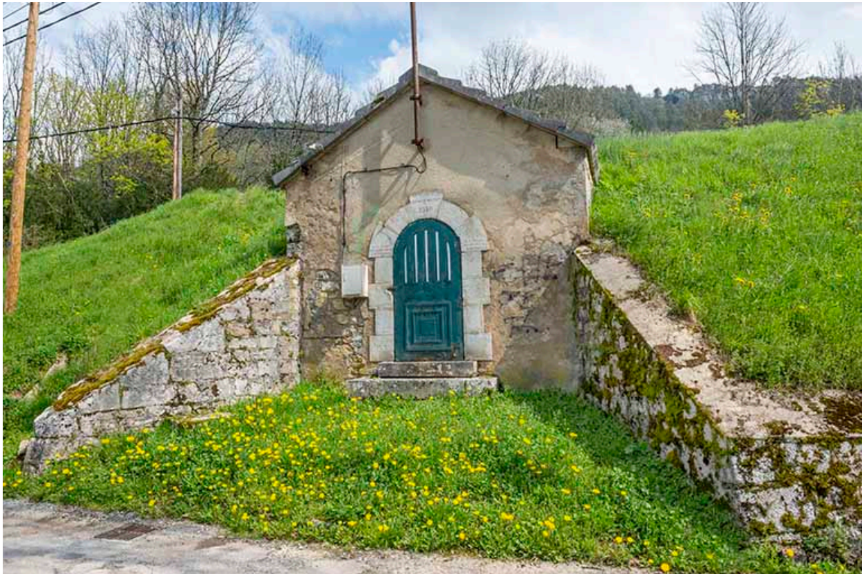
Réservoir de Chambenoz (1910). Côté ouest.
