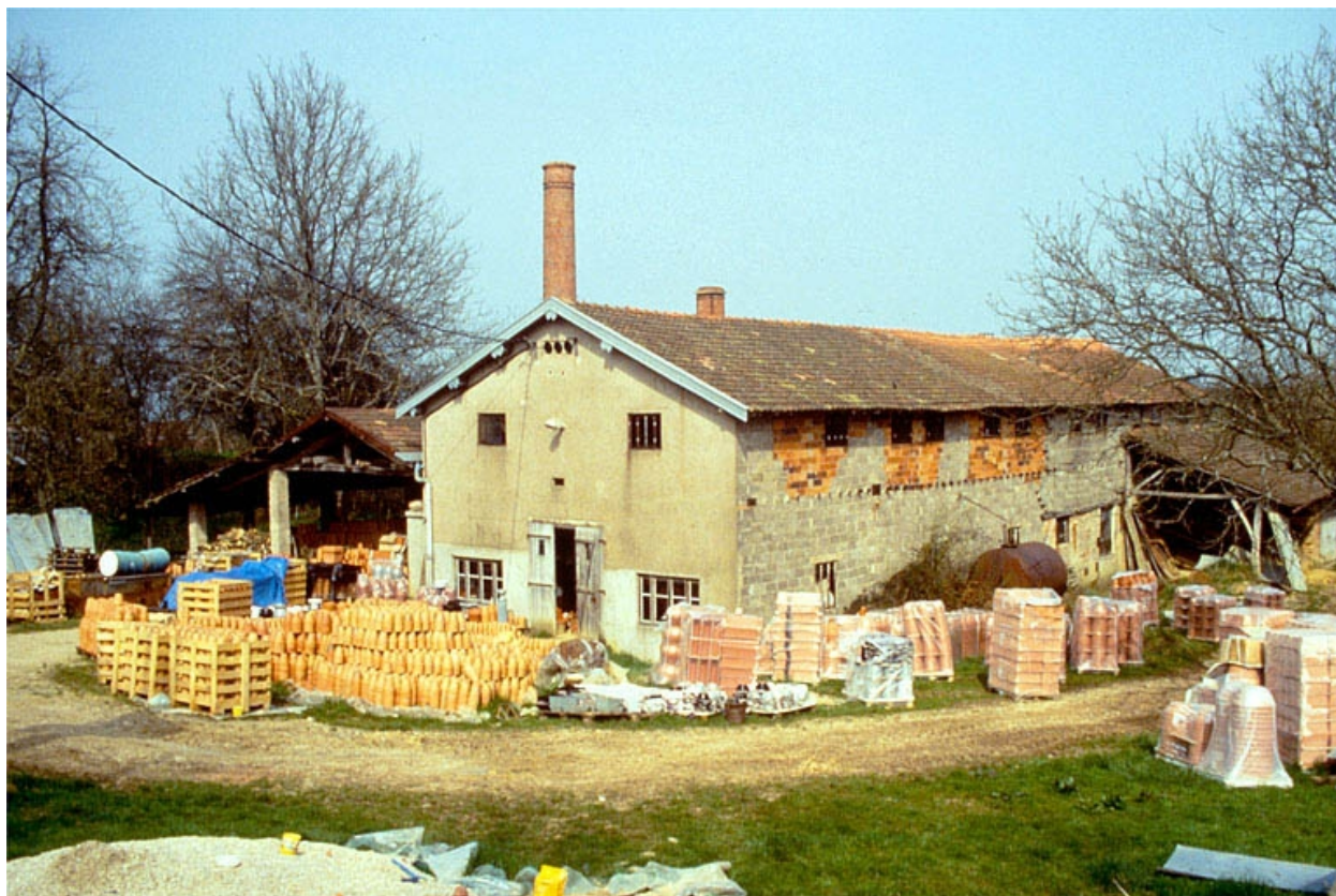
Façades antérieure et latérale droite.
