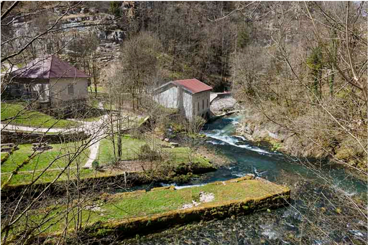
Vue d'ensemble depuis la source.
