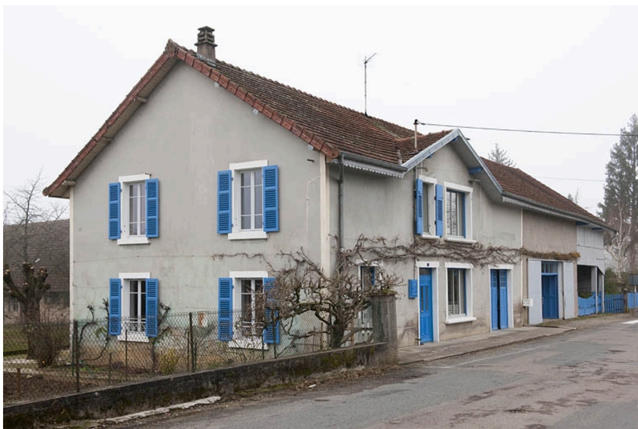
Façade antérieure et façade latérale gauche.
