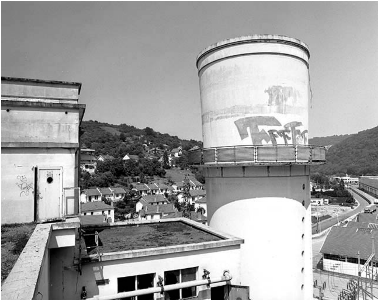
Château d'eau et cité ouvrière depuis le haut de l'atelier d'étirage nylon (NE3).
