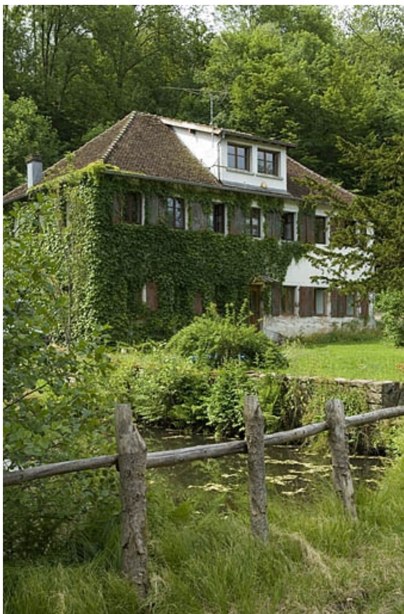
Ancienne saboterie, actuellement logement.
