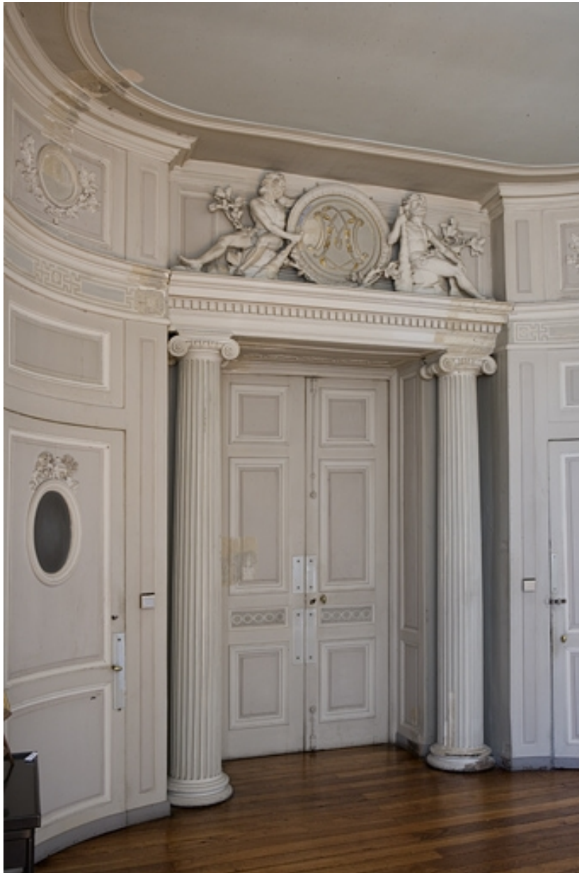
Hôtel en fond de cour, antichambre : vue d'ensemble de la porte menant au grand salon.
