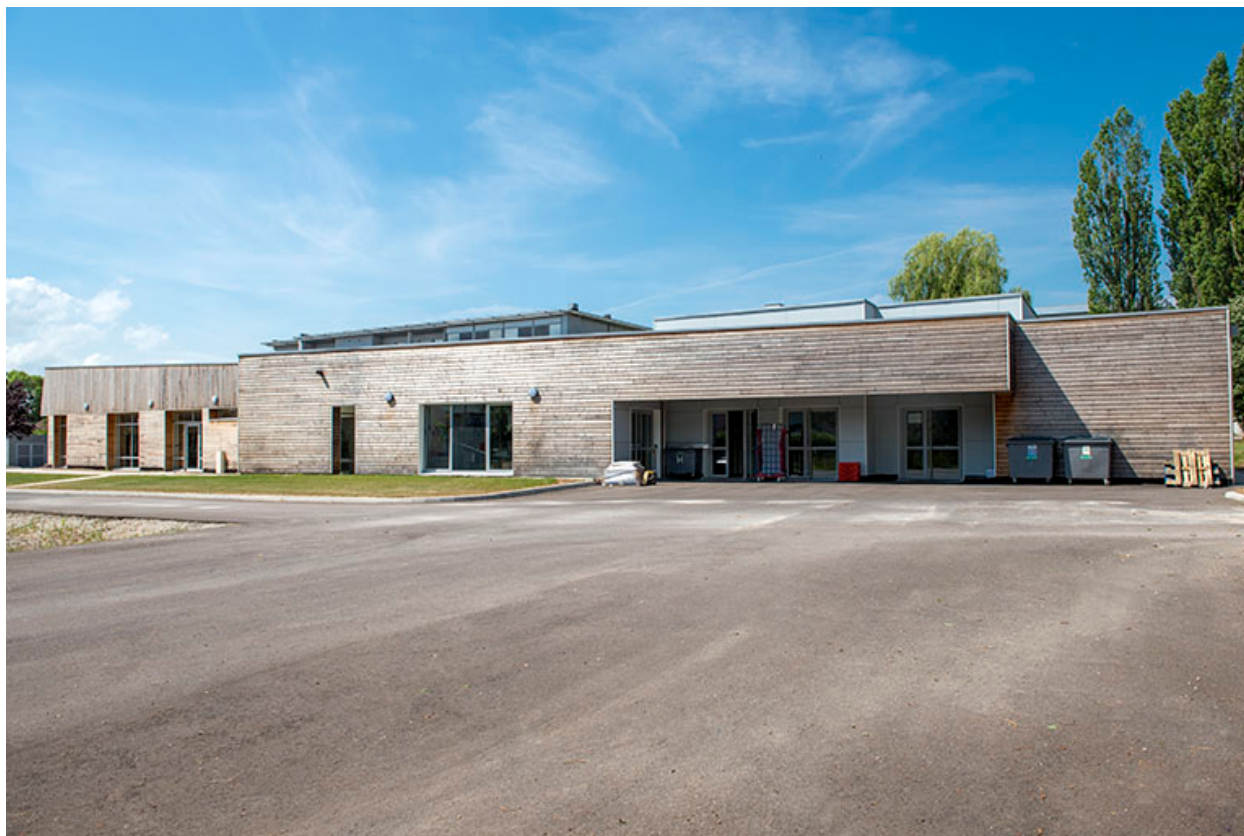
Façade nord-est de la cantine.
