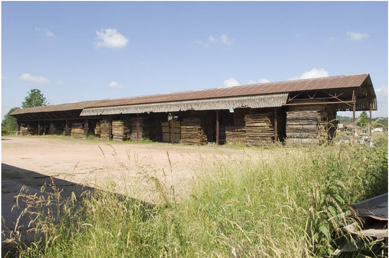
Entrepôt industriel ouest. Vue d'ensemble.
