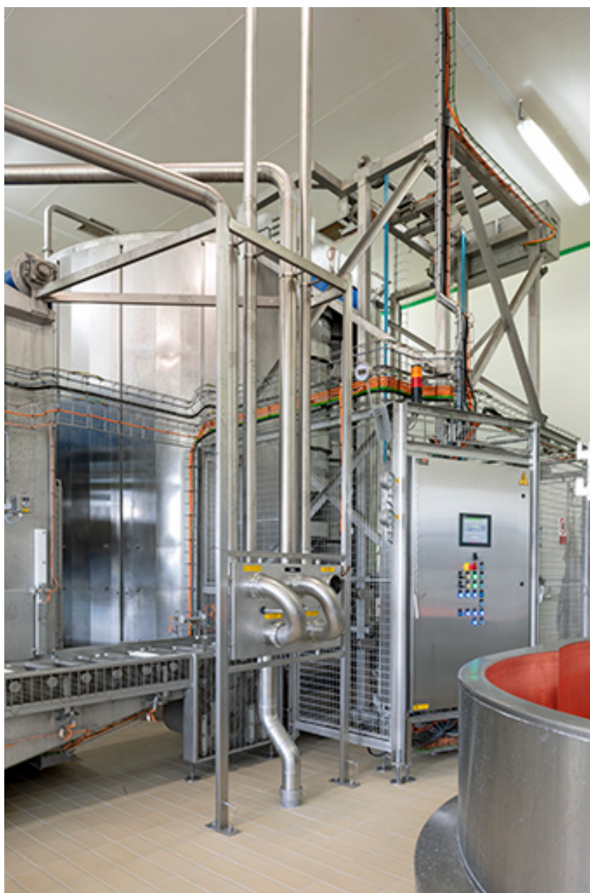
Installation de pressage (tour à l'arrière-plan).
