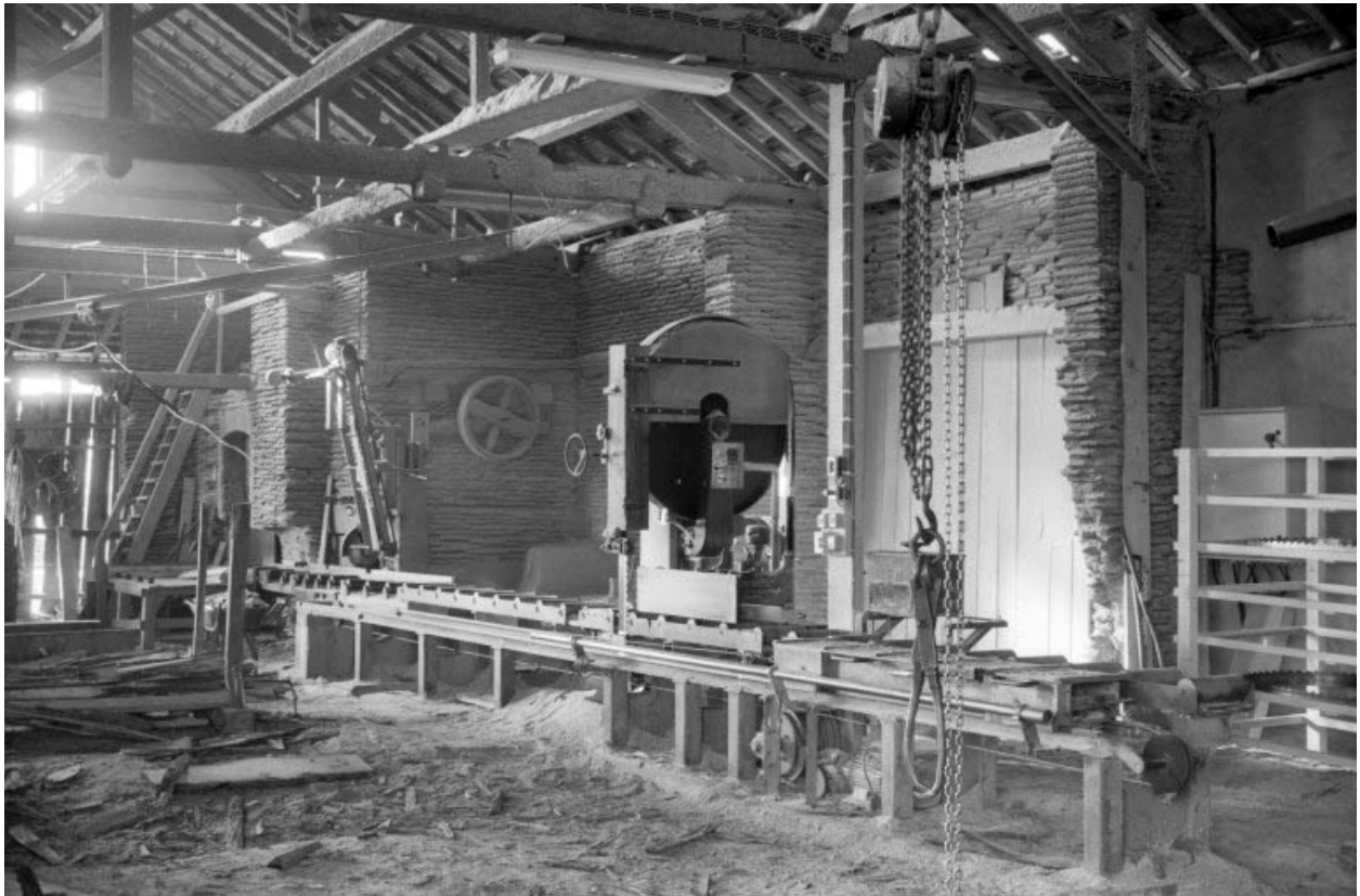
Intérieur de l'atelier de fabrication : scie Marcol.
