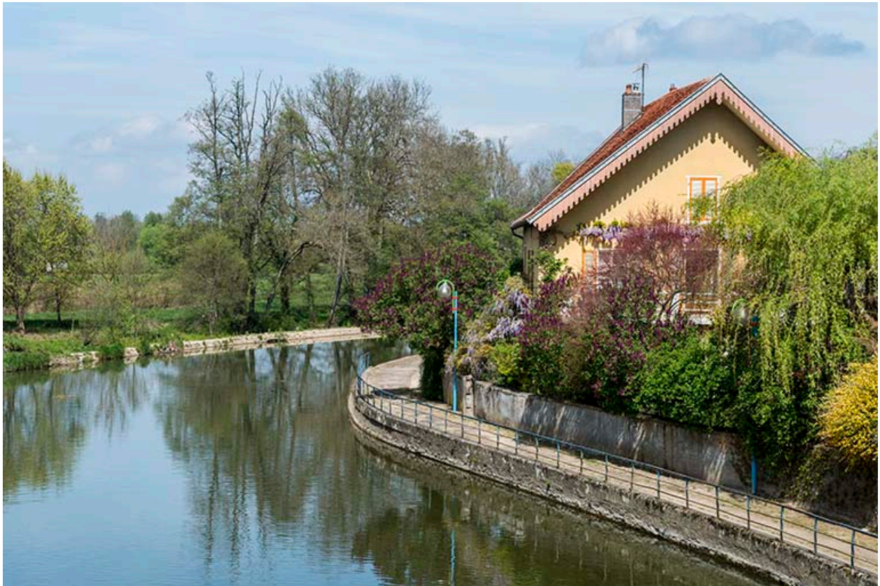
Vue sur le canal en amont de la porte de garde.
