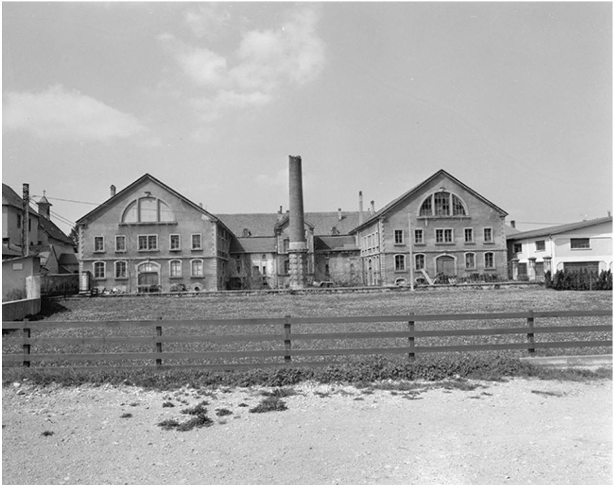
Façade postérieure des chais en 1980.
