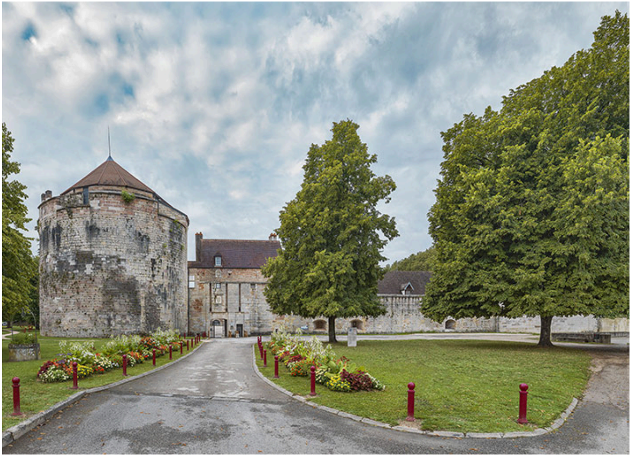
Entrée principale du château : vue d'ensemble.
