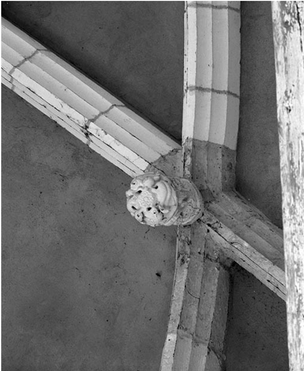
Choeur, détail : clef de voûte.
