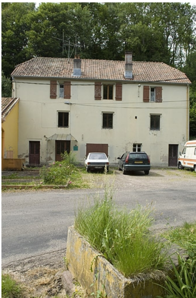
Façade antérieure de l'ancienne saboterie.
