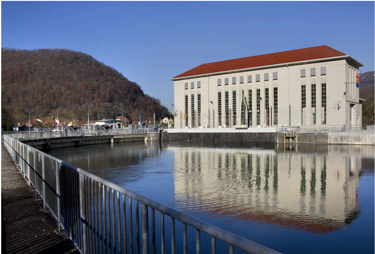
Bassin de retenue et salle des machines depuis le sud.
