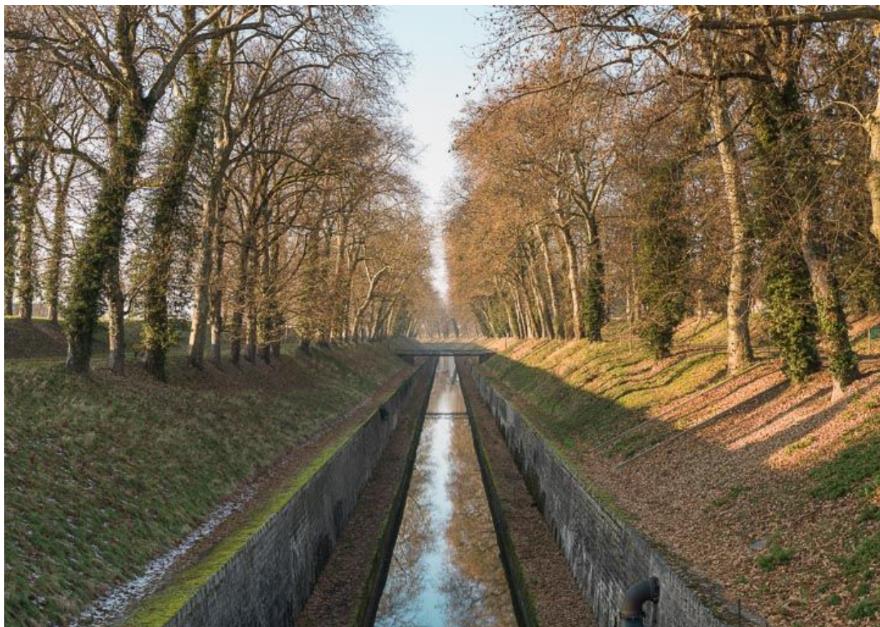
Vue d'ensemble de la tranchée.
