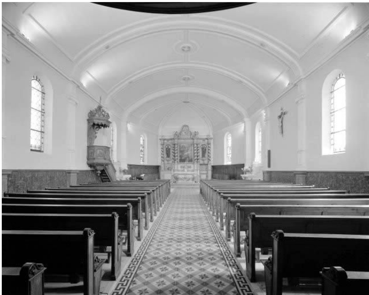
Intérieur : vue depuis l'entrée.
