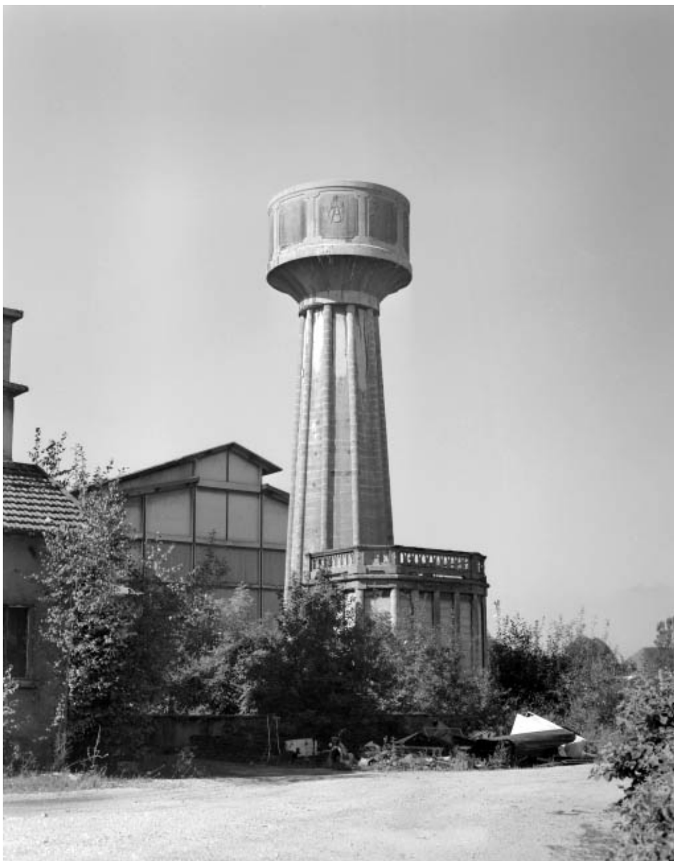
Le château d'eau.
