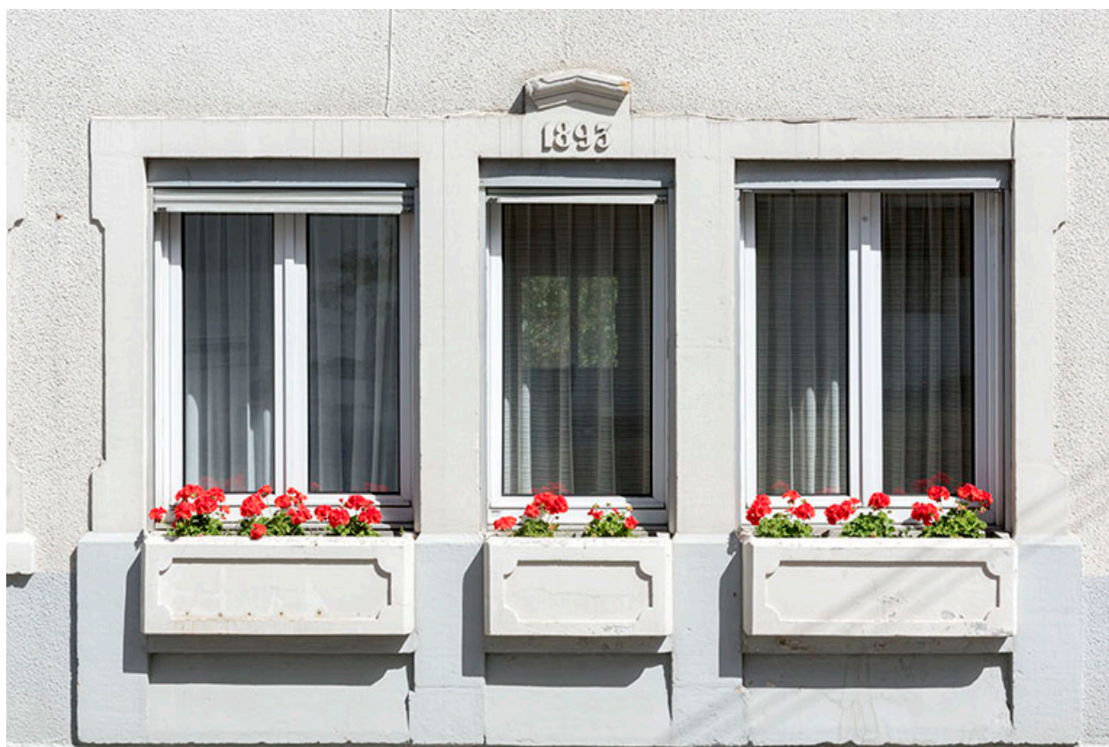
Façade antérieure : linteau daté.
