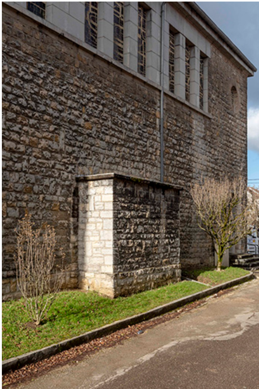
Détail extérieur du décrochement hors-œuvre abritant un confessionnal sur la façade latérale est.
