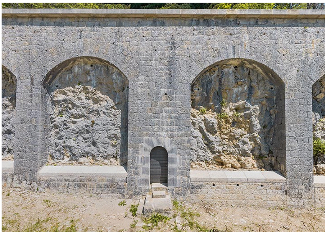
Front ouest : le rempart soutenu par ses arcs de décharge.
