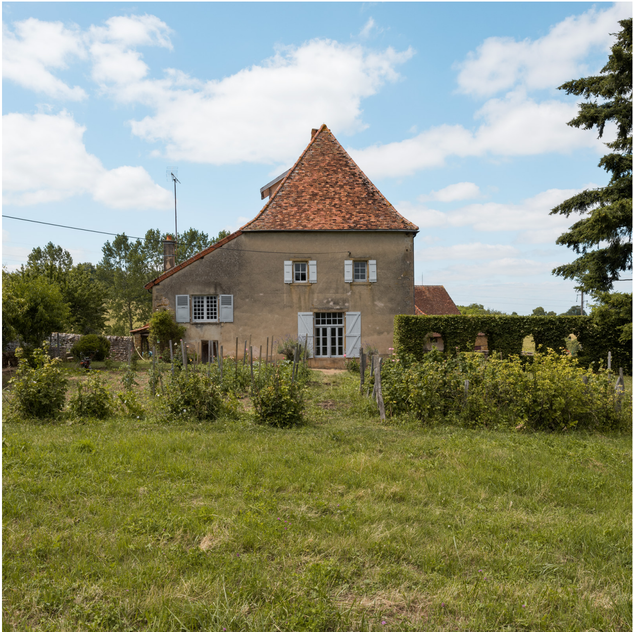
Façade sud du logement.
