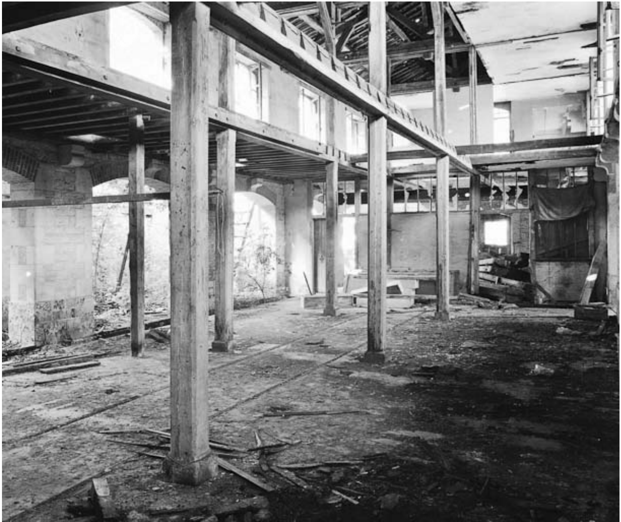
État en 1984, vue intérieure.
