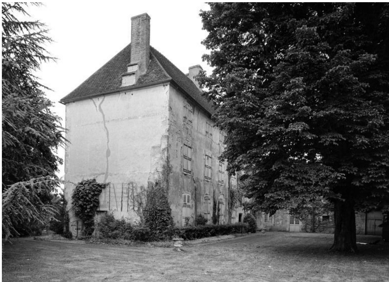
Bâtiment est. Vue d'ensemble.
