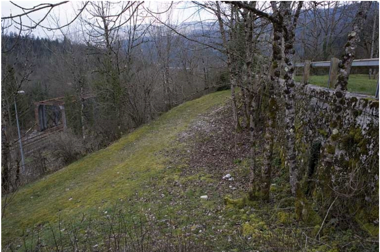
Réservoir (à droite) et son chemin d'accès.
