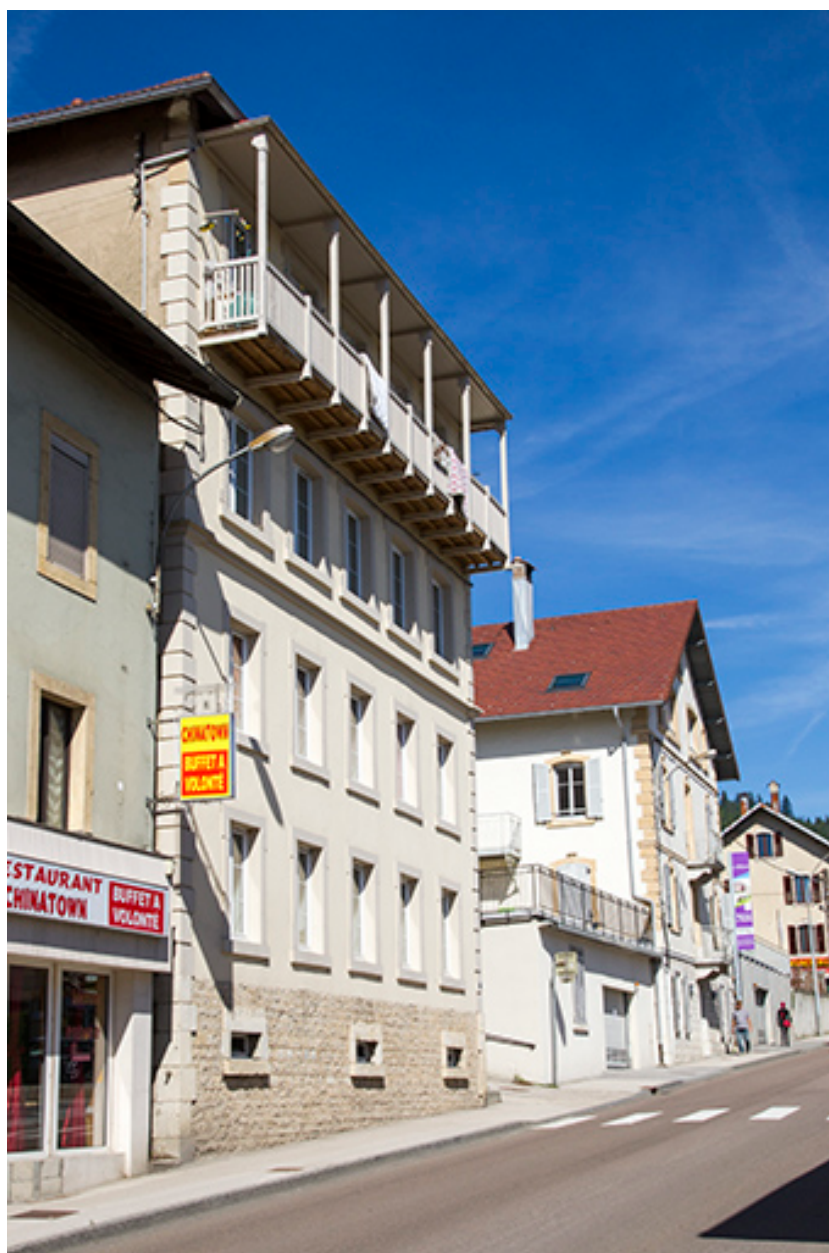
Usine : façade antérieure, vue en enfilade.
