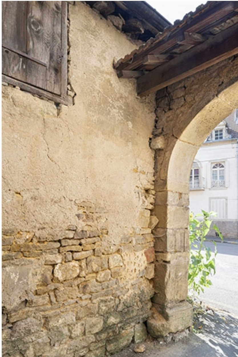
Détail de maçonnerie depuis la cour.
