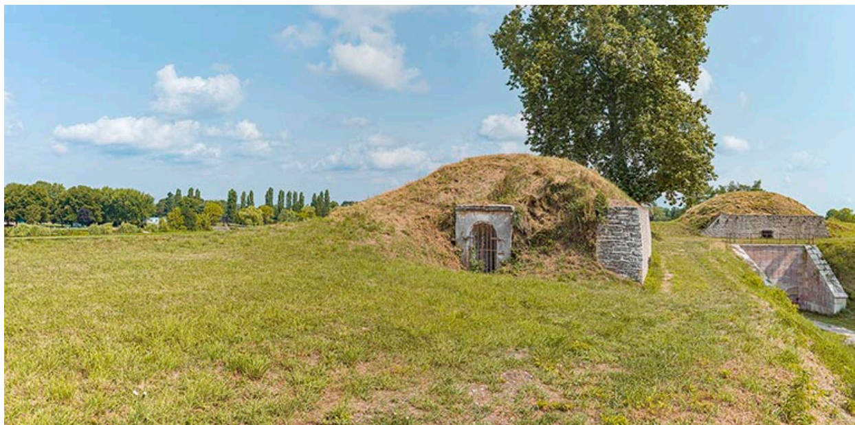
Entrée d'une des casemates sur le terre-plein.
