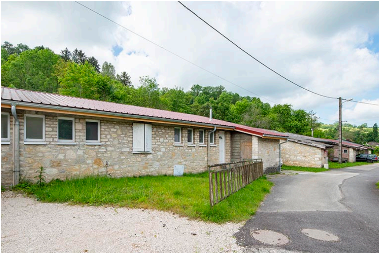
Vue d'ensemble des maisons jumelées.
