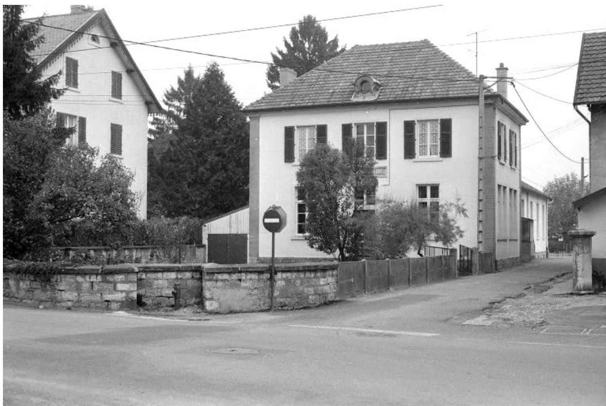
Ecole située avenue de la Gare.
