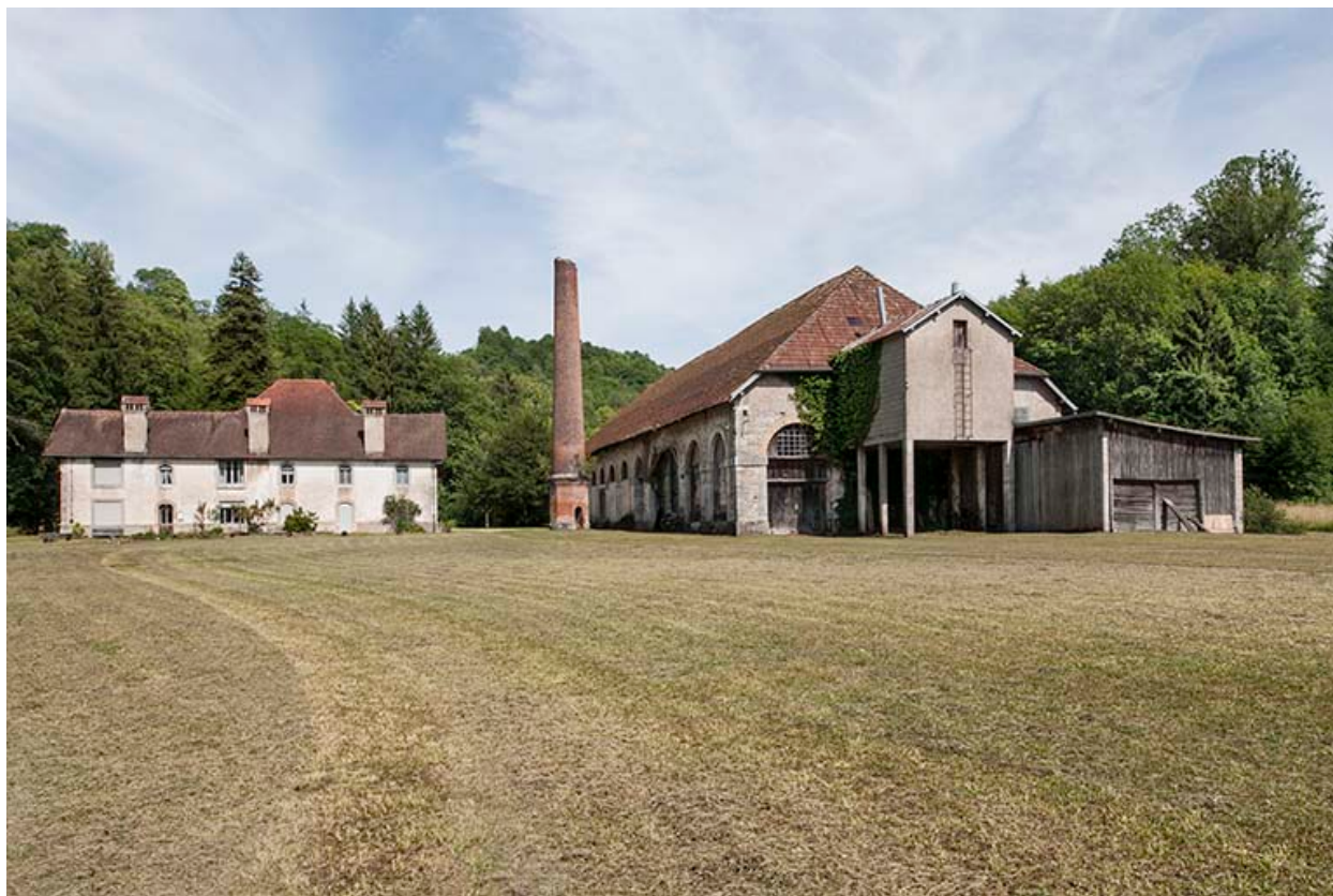
Vue rapprochée depuis l'ouest.
