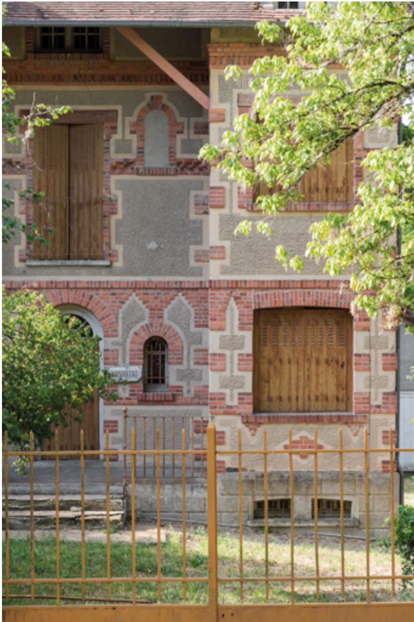
Façade principale, avant-corps latéral.
