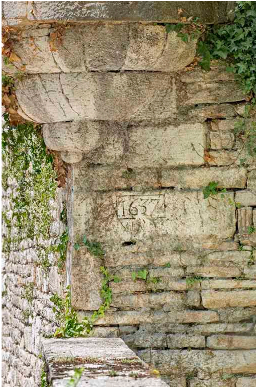
Culot de l'échauguette avec la date de construction du bastion.
