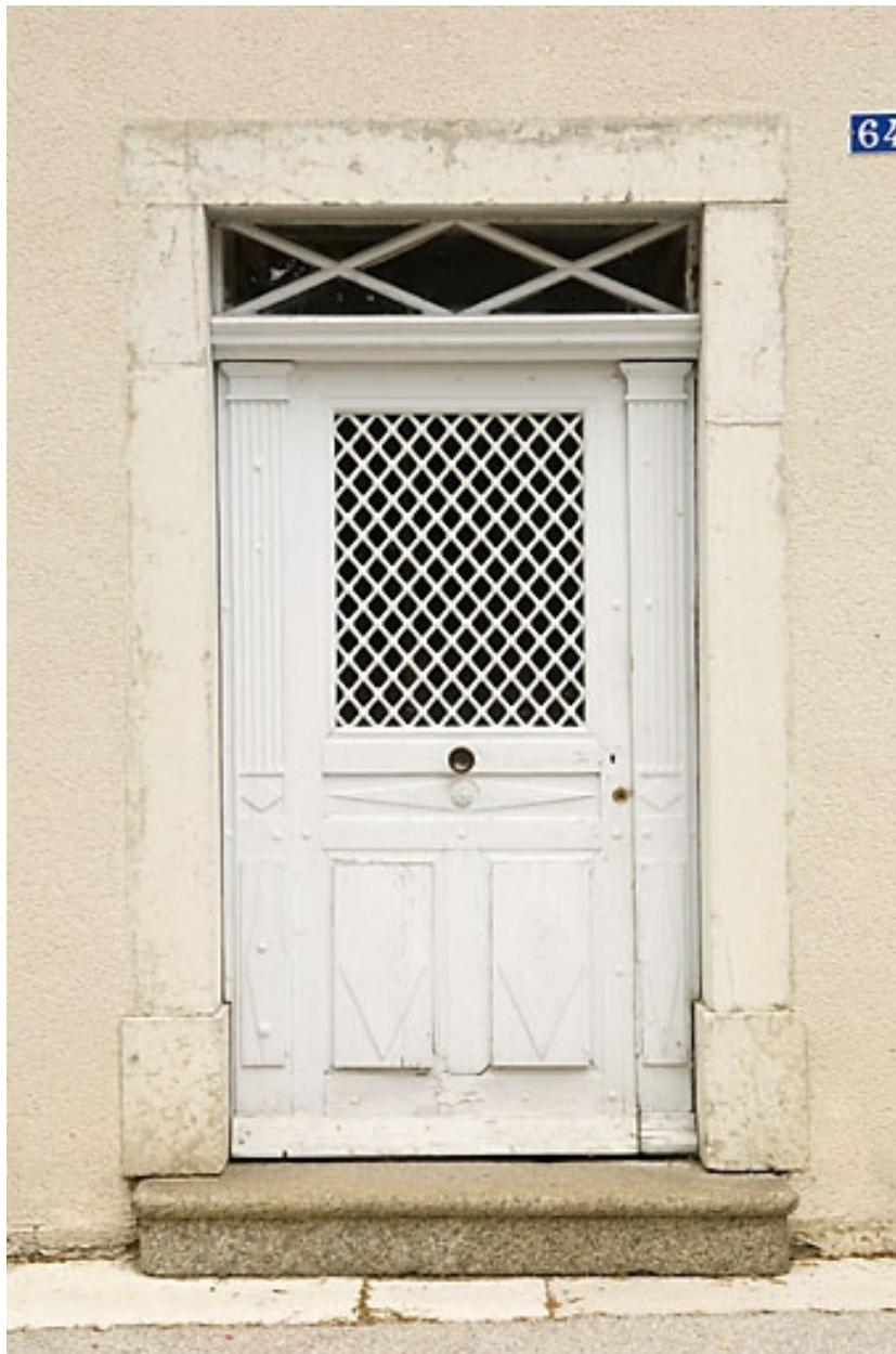
Bâtiment 62-64 rue des Forges : porte (64 rue des Forges).
