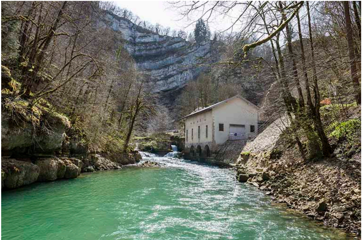
Vue générale depuis l'aval.
