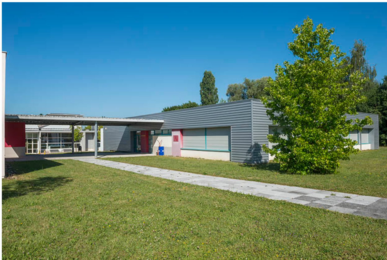
Angle sud-est du bâtiment de maintenance.(ex-Léger)
