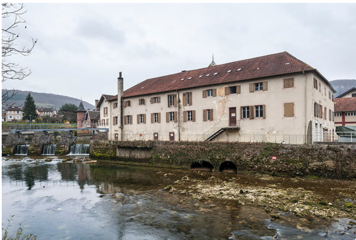
Façade nord du bâtiment du moulin.
