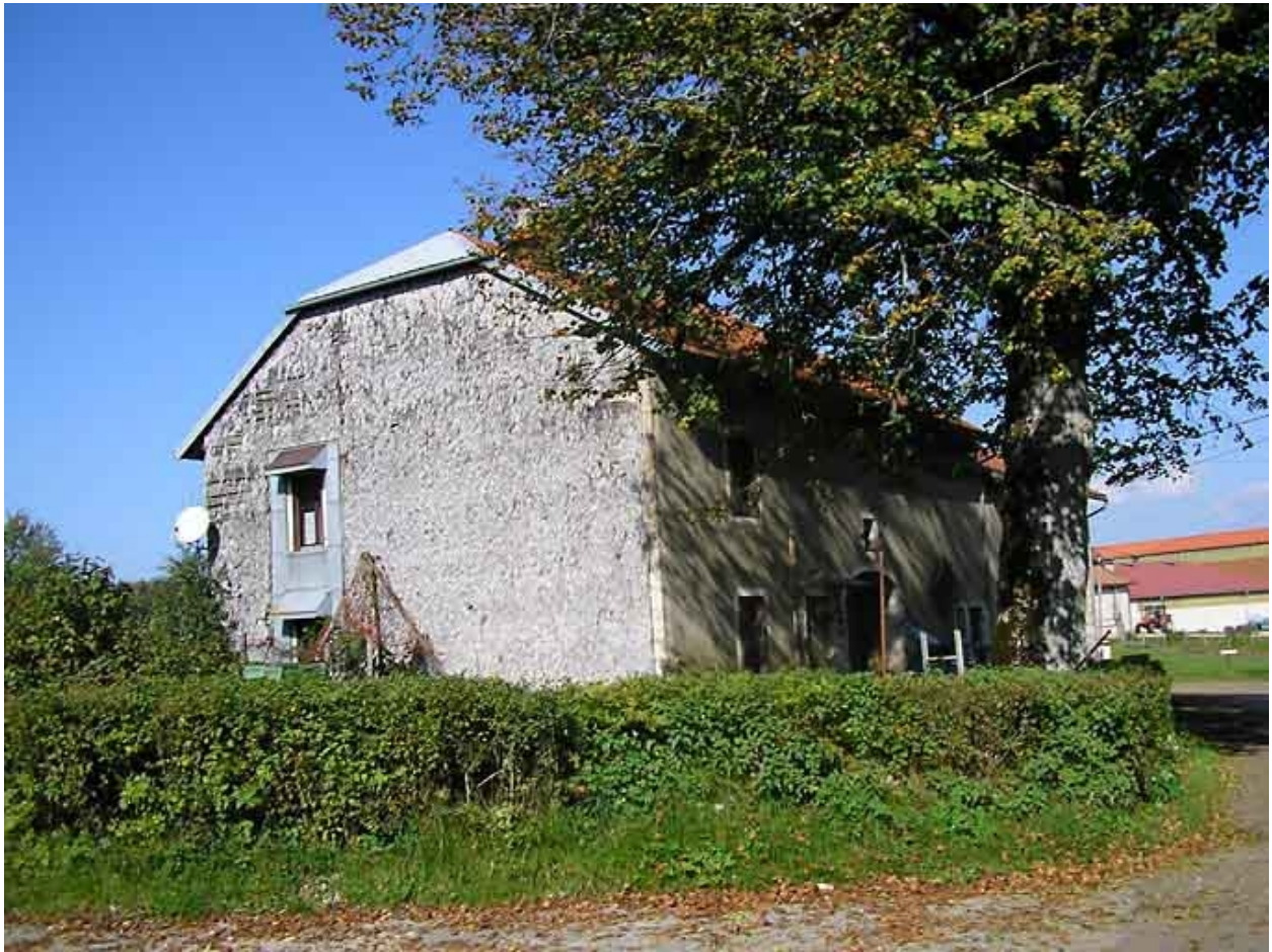
Pignon sud-ouest vu de trois quarts.
