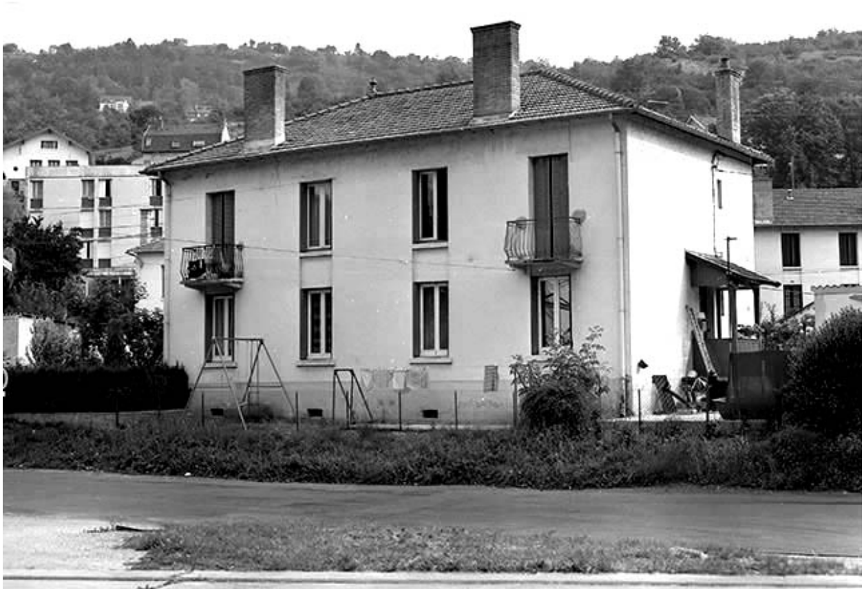
Façade postérieure d'une maison de type IIIb (3, cité Rhodiacéta).
