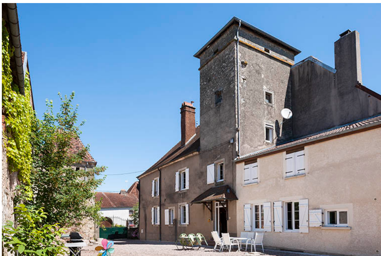
Vue générale, façade ouest.
