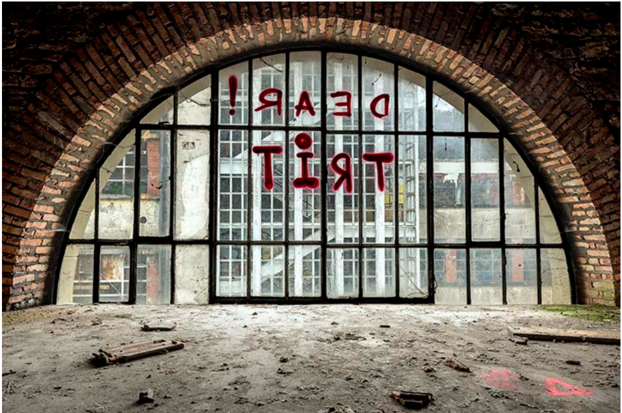
Etat en 2016. Usine A : baie en arc plein cintre à l'étage en surcroît de la chaufferie.
