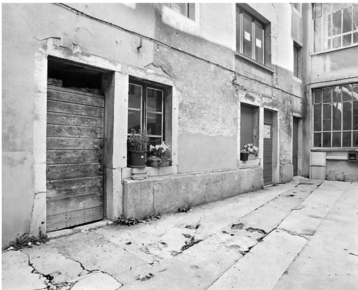
Aile nord : rez-de-chaussée, de trois quarts gauche.
