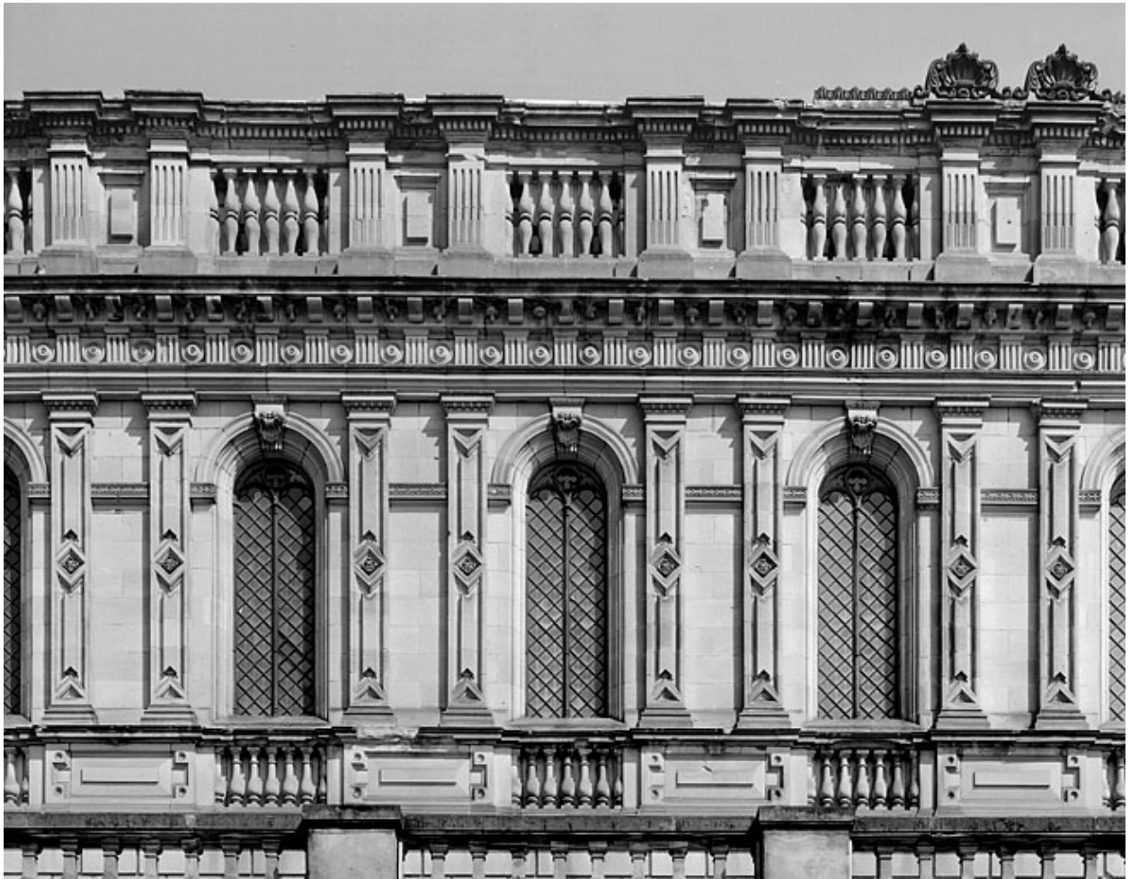
Elévation du deuxième niveau de la nef, côté sud.
